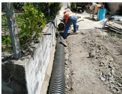
Queixoperra: Conduta águas pluviais
