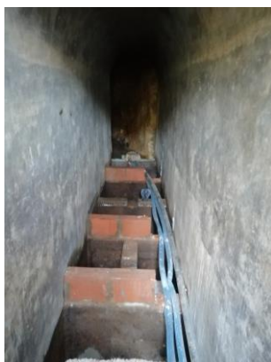
Aboboreira: Limpeza de Mina
